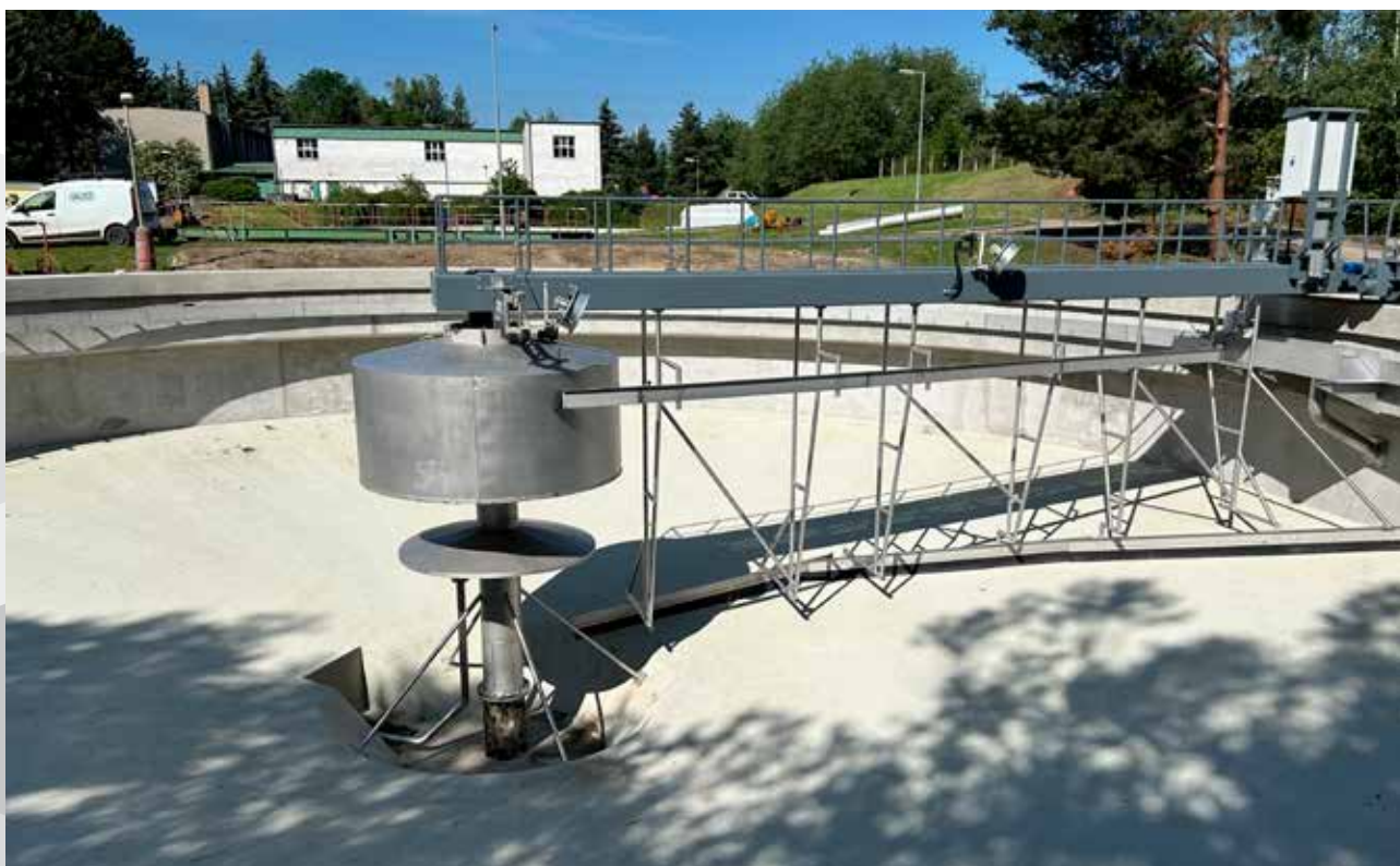
■ Zrekonstruovaná dosazovací nádrž v areálu čistírny odpadních vod Kladno - Dubí
