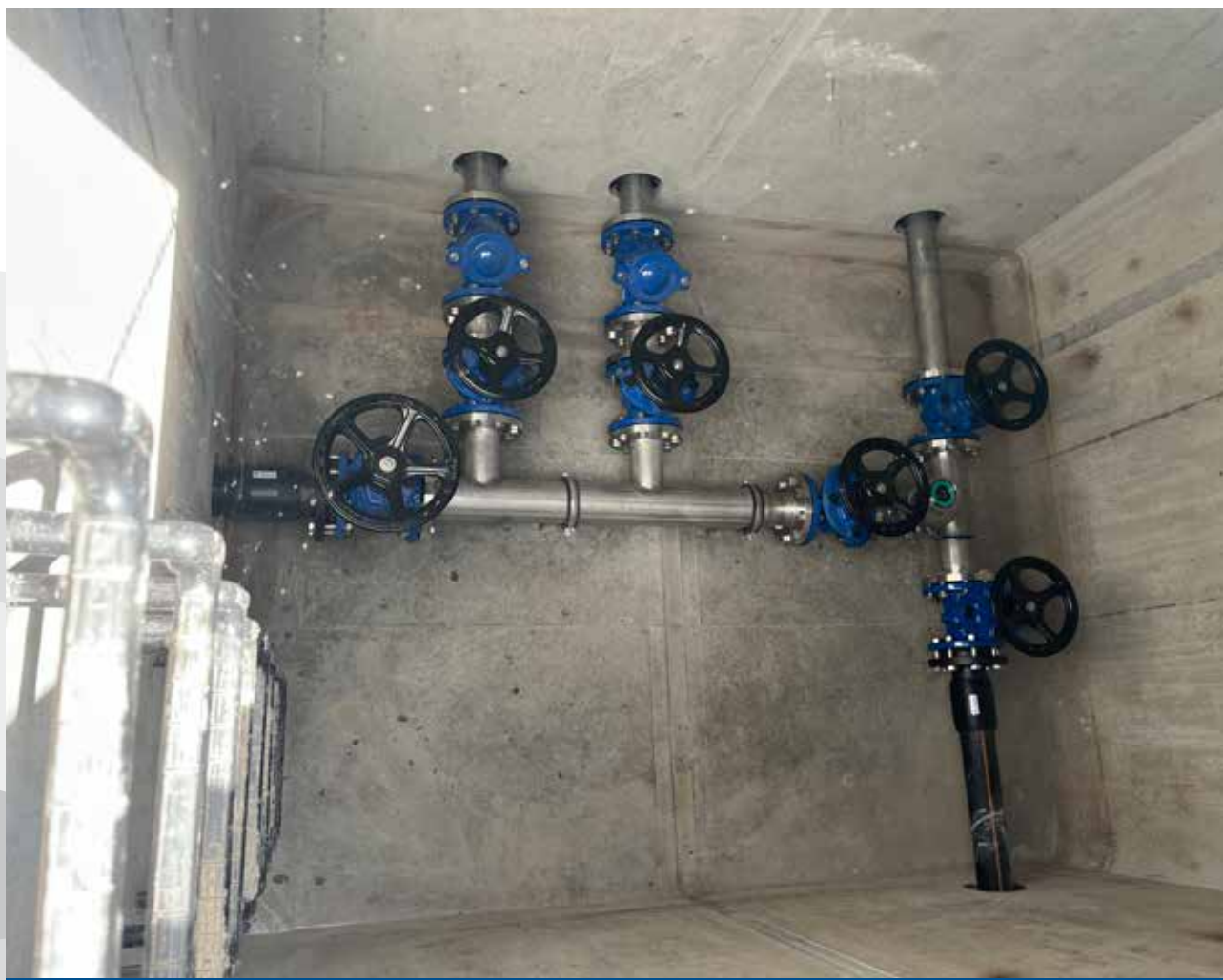
■ Vystrojení armaturní šachty v areálu čistírny odpadních vod Nebužely
