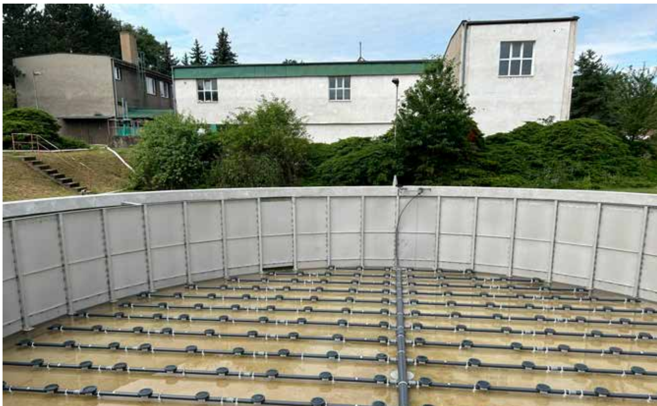
■ Nová technologie v sanované nádrži v areálu čistírny odpadních vod Kladno - Dubí
