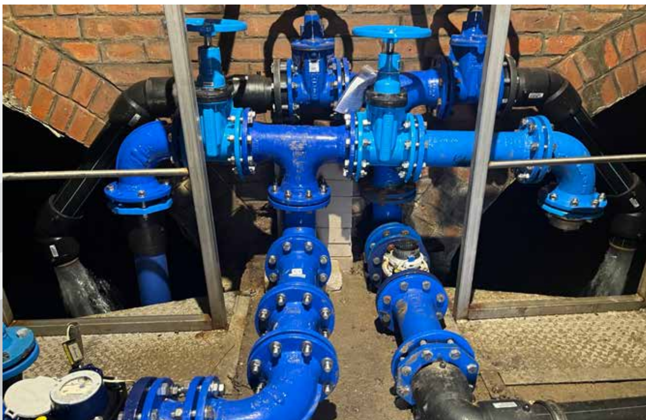
■ Nové vystrojení vodojemu Libušín při rekonstrukci přivaděče
