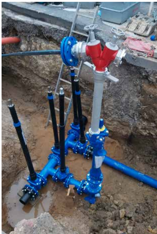
■ Armaturní uzávěry na vodovodu v ulici U Cihelny v Mělníku
