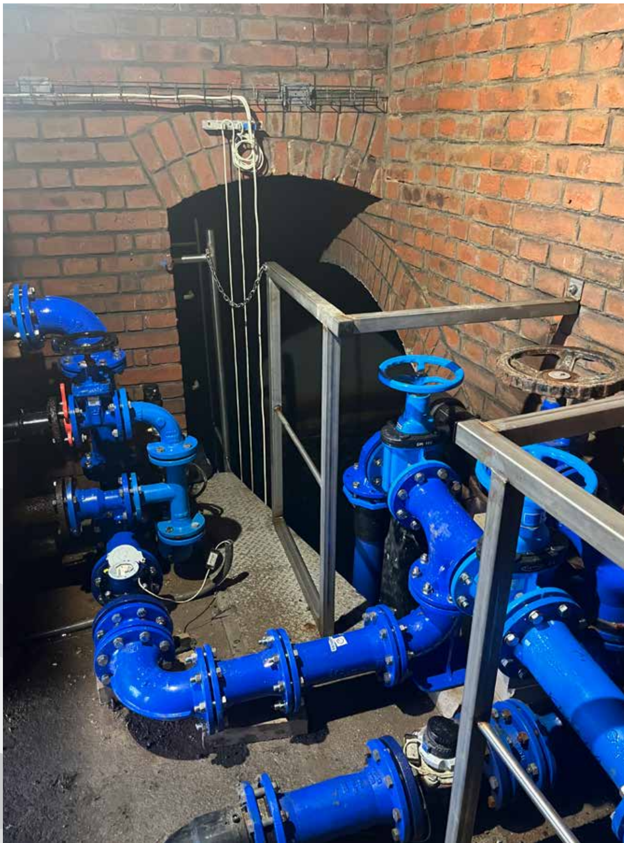
■ Nové vystrojení vodojemu Libušín při rekonstrukci přivaděče
